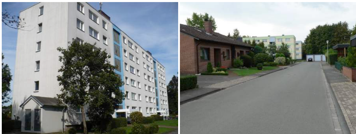
Foto 1 und Foto 2: Wohngebäude Dessauer Straße (links) und Plauener Straße (rechts)
