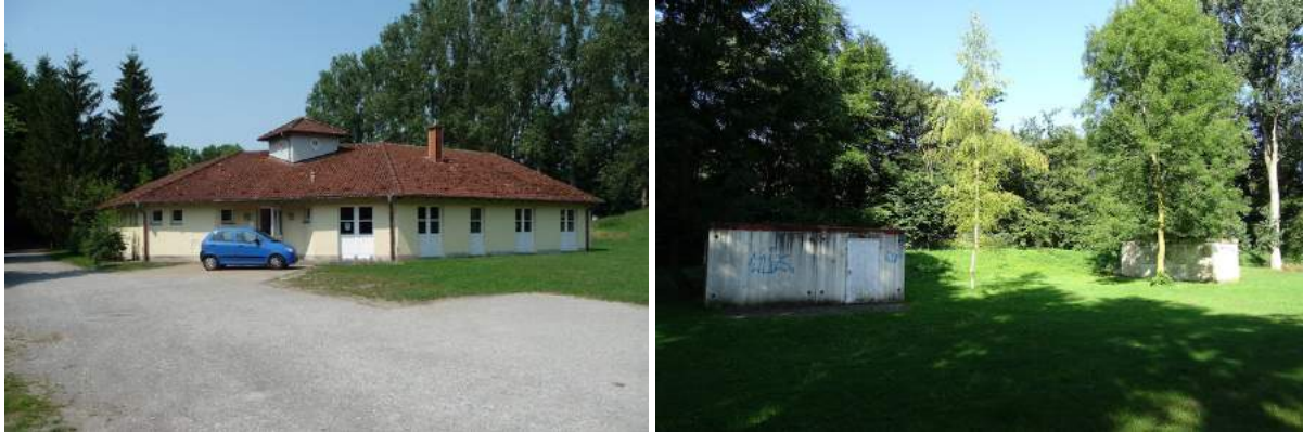
Foto 21 und Foto 22: Gebäude Bürgerzentrum Lukas (links) und Freifläche (rechts)
