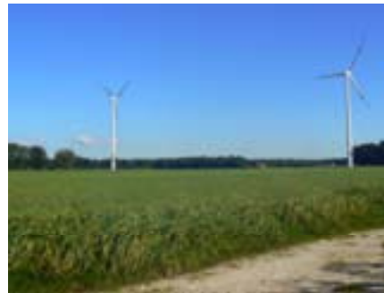
Windkraftanlagen im Bereich Dürerweg
